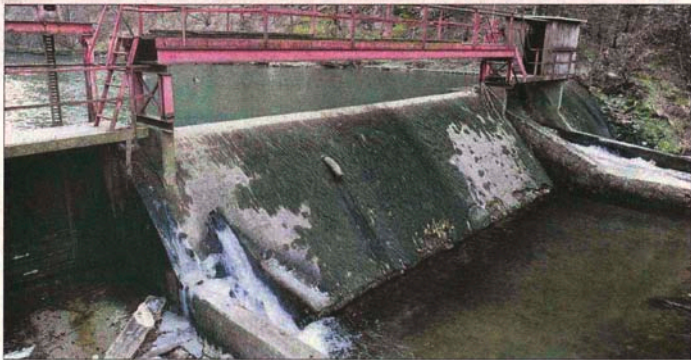
La Birse a retrouvé un semblant de débit dans les gorges de Court, entre le barrage (ci-dessus) et l'usine électrique. Mais cela pénalise la production d'énergie. Page 10
