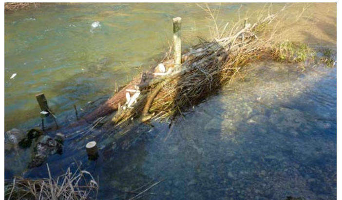
Faschinenbau, Bild Ernst Hänzi
