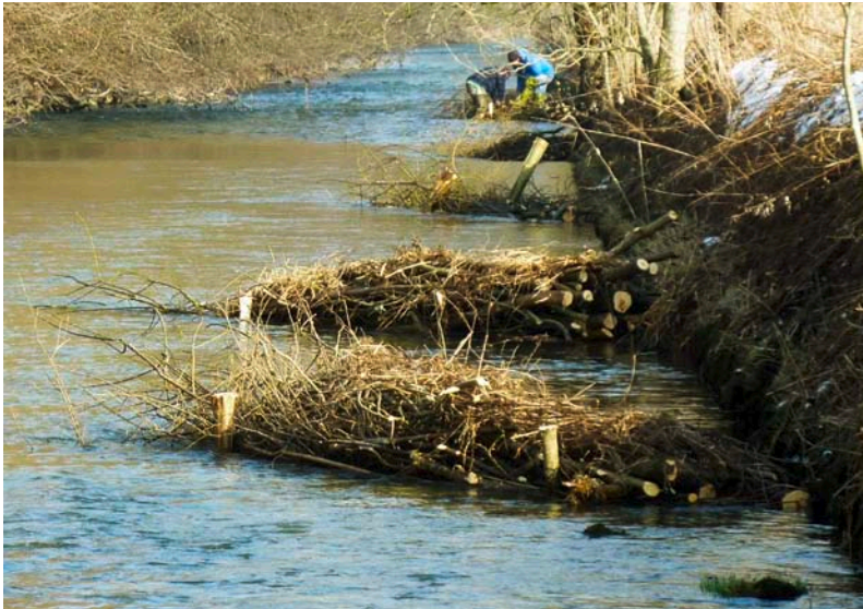
Bild links: Faschinen in der Schüss bei Cortébert Bild rechts Vorzeigefaschine (Bilder Jüre Knörr)
